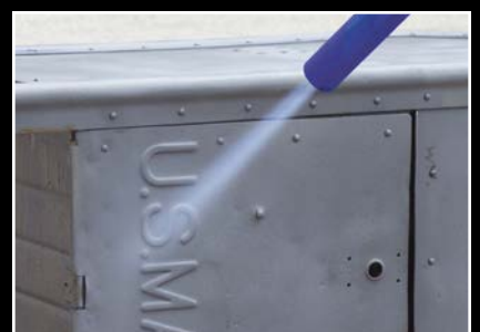
Förbehandling av stålytor
