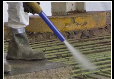
Reparation och restaurering av betong
