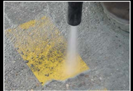
Förbehandling av betongytor
